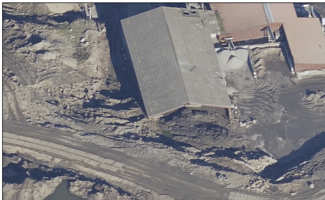
Figur 9. Skråfoto fra 1. april 2023, som viser, hvordan jordskredet har bevæget sig helt ind i en stor lagerhal, som halvanden måned forinden havde fået nedrevet 15 meter af dets vestlige ende. Synsretningen er mod øst.
