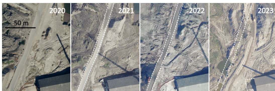
Figur 8. Udsnit af forårs-ortofoto fra 2020–2023, som viser forflytningen af en vej samt delvis nedrivning af lagerhal. De stiplede linjer viser forløbet af vejen i 2020 samt den oprindelige udstrækning af lagerhallen. Se Figur 4 for placering.
