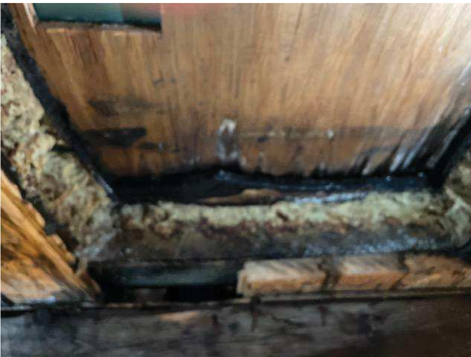
Foto nr. 21. Tidligere åbning af oprindelig tagkonstruktion til undersiden af krydsfiner-plade ifm. skotrende.
