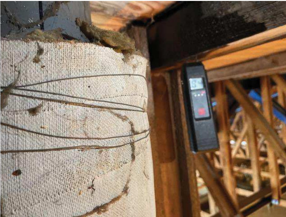
Foto nr. 20. Fugtindhold i spærhovede blev målt til 84%, og der var synlig opfugtig af spærkonstruktion.
