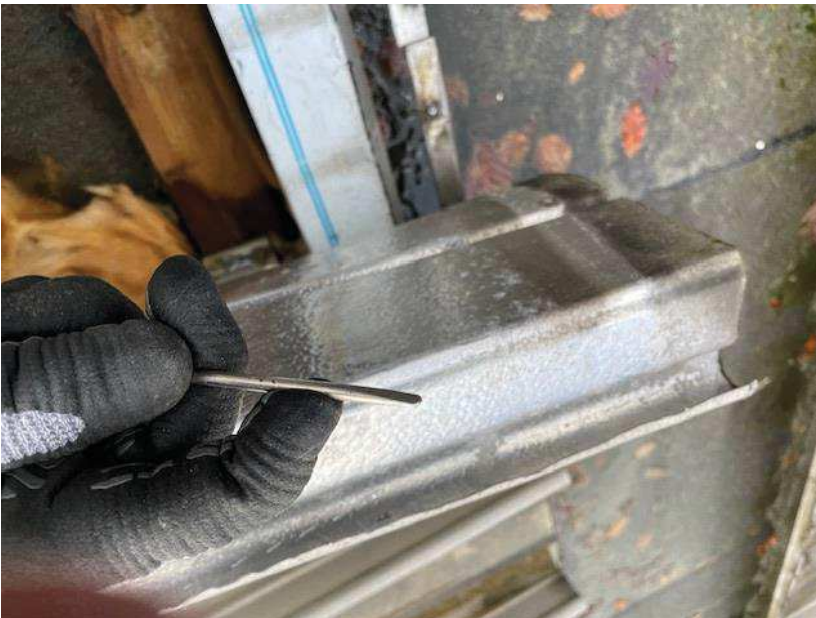
Foto nr. 18. Trælægten var meget mørnet – skruetrækker kunne stikkes ca. 25 mm ned i lægten.
