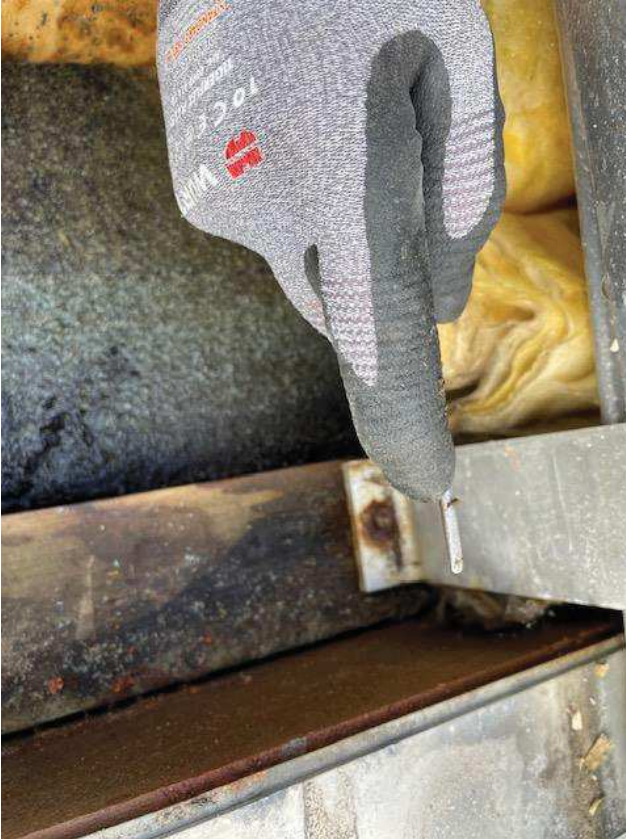
Foto nr. 7. Trælægten er meget mørnet. Skruetrækker kunne stikkes ca. 25 mm ind i træet.
