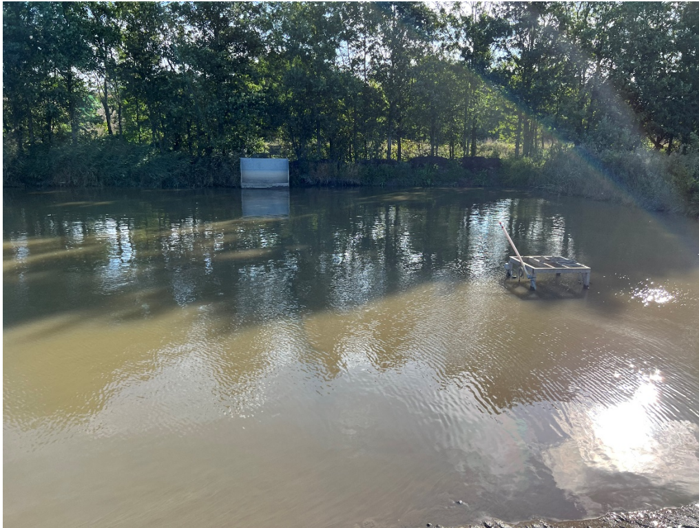
Billede 2: Bagkant forstærkning af bassinet er fortaget med rent ler, og efterfølgende afdækning med et mundlag.
