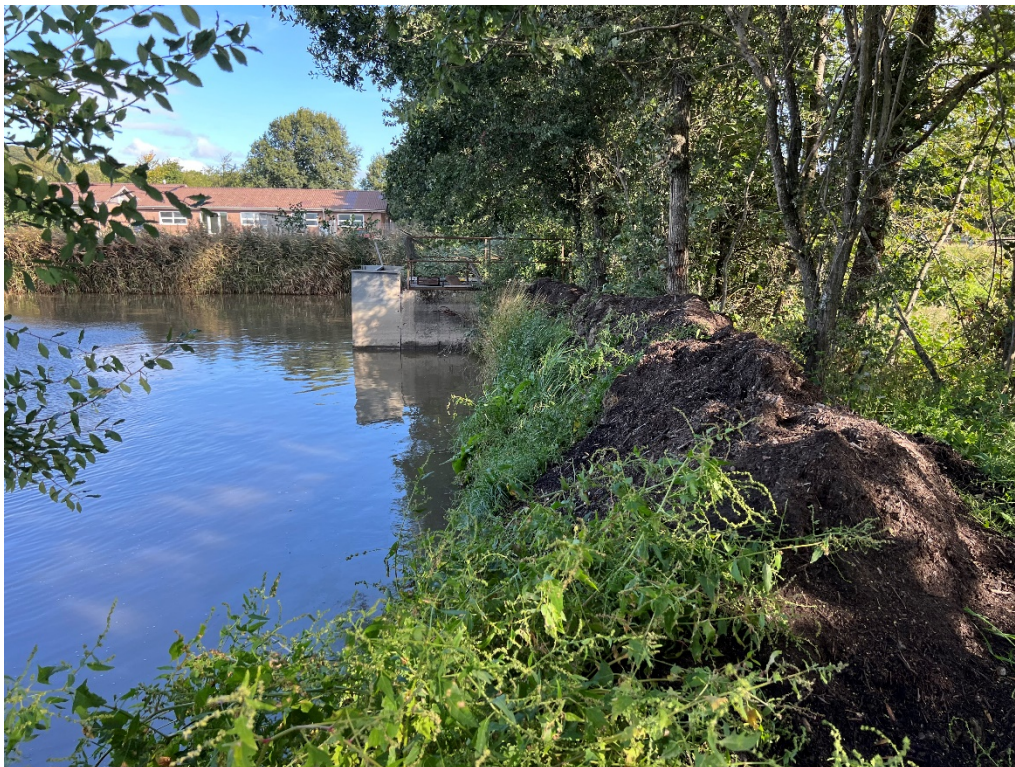
Billede 1: Bagkant forstærkning af bundfældningsbassin til overfladevand er forhøjet med 1,5 meter i forhold til den højde bassinet havde i marts 2022.
