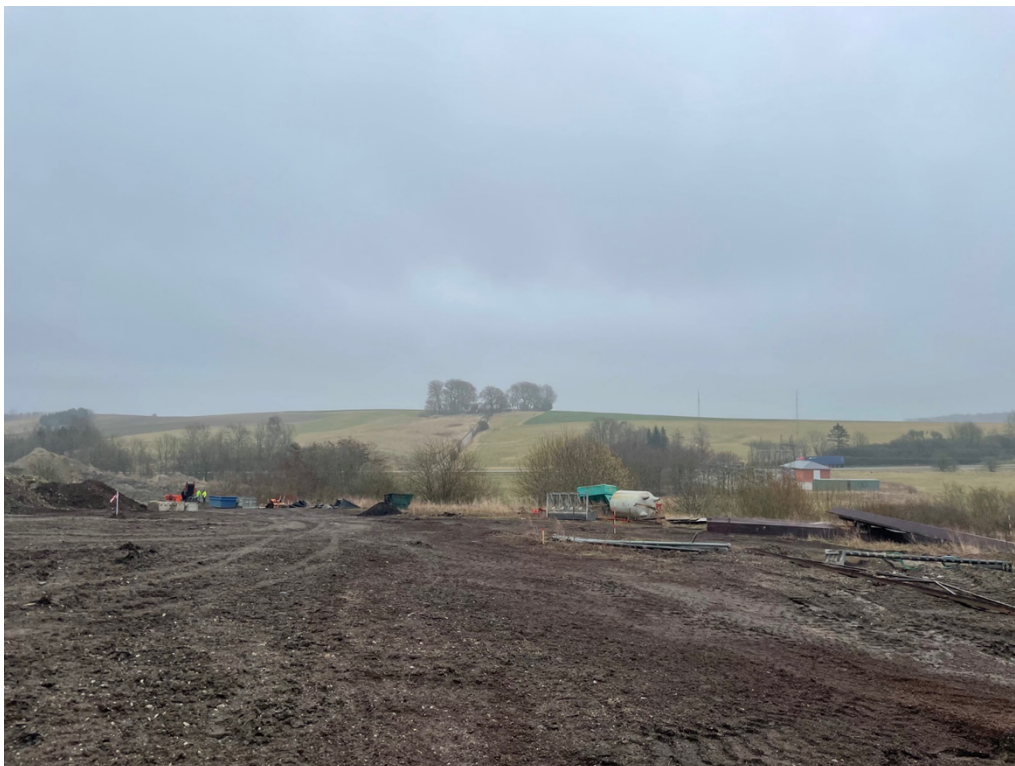
Figur 4 - Foto taget ved besigtigelsen set mod øst. Fotoet er taget ved den vestlige del af åbesskyttelseslinjens udbredelse. De røde pinde angiver den forventede placering af jordvolden.
