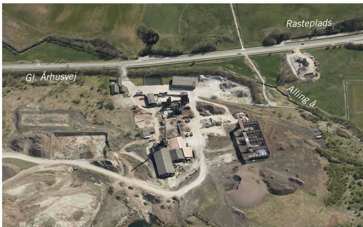
Billede 1: Skråfoto af området med bebyggelse ved Gl. Århusvej og Alling å.
