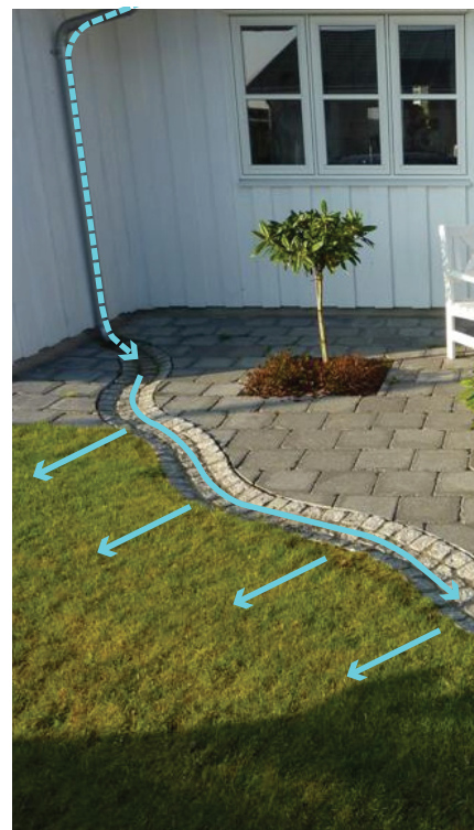
Figur 6: Regnvand ledes i en tæt rende bort fra huset til nedsivning i græsplænen. Trekroner, Roskilde. Foto Orbicon.
