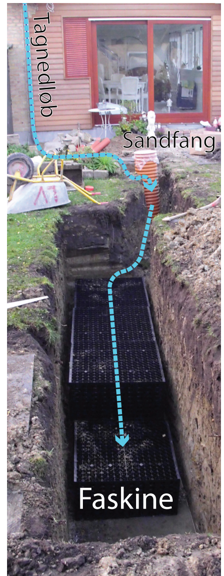
Figur 4: Faskine under udførelse. Tagvandet ledes via en sandfangsbrønd (lodret orange rør) til faskinen i billedets forgrund. Denne faskine er opbygget af plastkassetter. Lindevang, Brøndby. Foto Spildevandscenter Avedøre.
