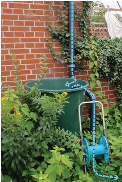
Figur 7: Tagvandet ledes via nedløbsrøret til regnvandstønden. Når tønden er fuld, ledes vandet i overløb til et andet nedsvivningselement i haven. Tønder fås i flere varianter, og kan som i dette tilfælde skjules af beplantning. Slagslunde, Egedal Kommune. Foto Orbicon.
