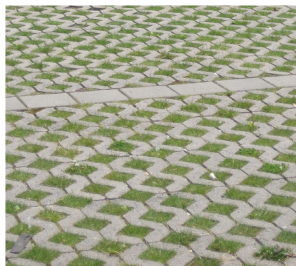
Figur 8: En permeabel belægning er en fast overflade, hvor vandet på grund af fugerne/mellemrummene kan sive igennem. Vestre Hamn, Malmø. Foto Orbicon.
