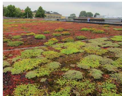
Figur 9: Grønt tag tilplantet med sedum. Augustenborg, Malmø. Foto Orbicon.
