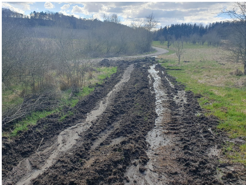
Figur 1 Kørevej med erosion mod Alling Å. Relativt lille materialetransport på dagen.
