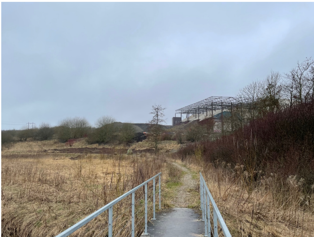
Figur 6 - Foto taget ved besigtigelsen. Fotoet er taget ved broen der går over Alling å set mod vest.
