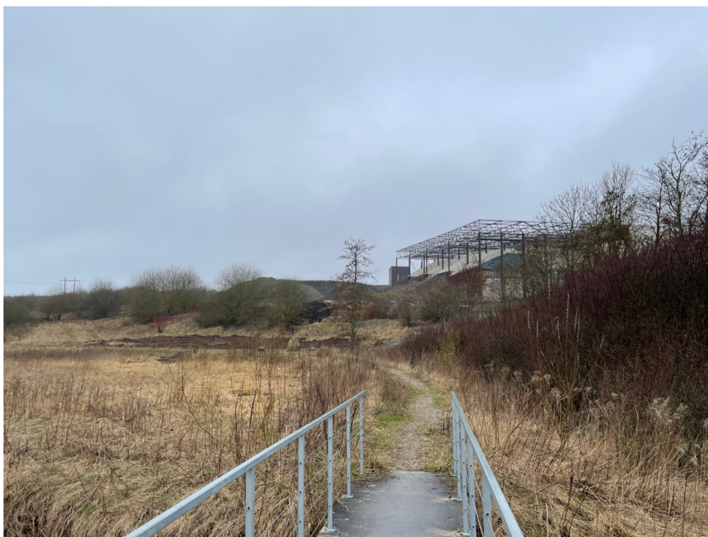
Figur 6 - Foto taget ved besigtigelsen. Fotoet er taget ved broen der går over Alling å set mod vest.
